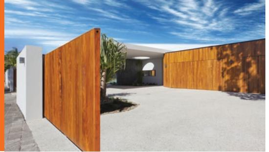
Schiebetore kommen zum Einsatz, wenn kein Platz für die ausschwingenden Flügel eines Drehtores vorhanden sind, oder große Durchgänge verschlossen werden sollen.
