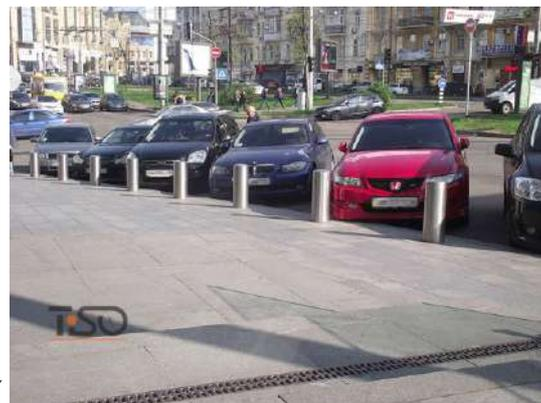
2.2 Благодаря конструктиву и широкому модельному ряду боллардов в разных размерах с высотой перекрытия, материалами и диаметрами цилиндра, эти устройства есть отличным дополнением к различным городским архитектурным концепциям; Глубина установки позволяет легко и быстро установить этот боллард. Съёмный столб снимается простым поворотом специально поставленного ключа.
